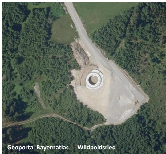
WEA-Bauplatz im Wald
